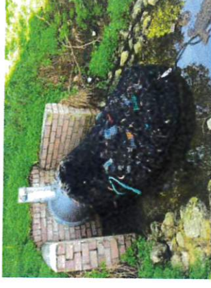
Filet de retenue installé à Marseille (Made In Marseille, 2019)
